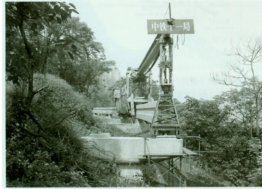
그림-4 手延工法에 의한 PC케도 beam 가설상황
